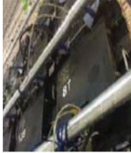
Kurulumu sağlamlaştırmak için Ethernet kablosu kullanılmış yanlış bir uygulama
